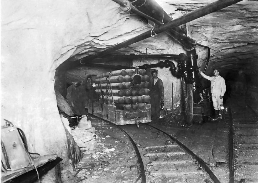
Abb. 5: Arbeiter im Simplontunnel (Foto: Mediathek Martinach)
