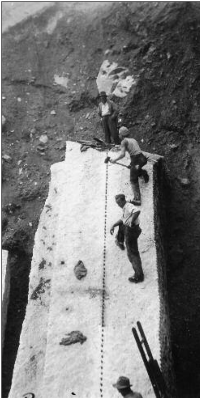
Fig. 7 - Débit d'un bloc de granite dans une carrière de l'entreprise Travaglini à Ravoire.
