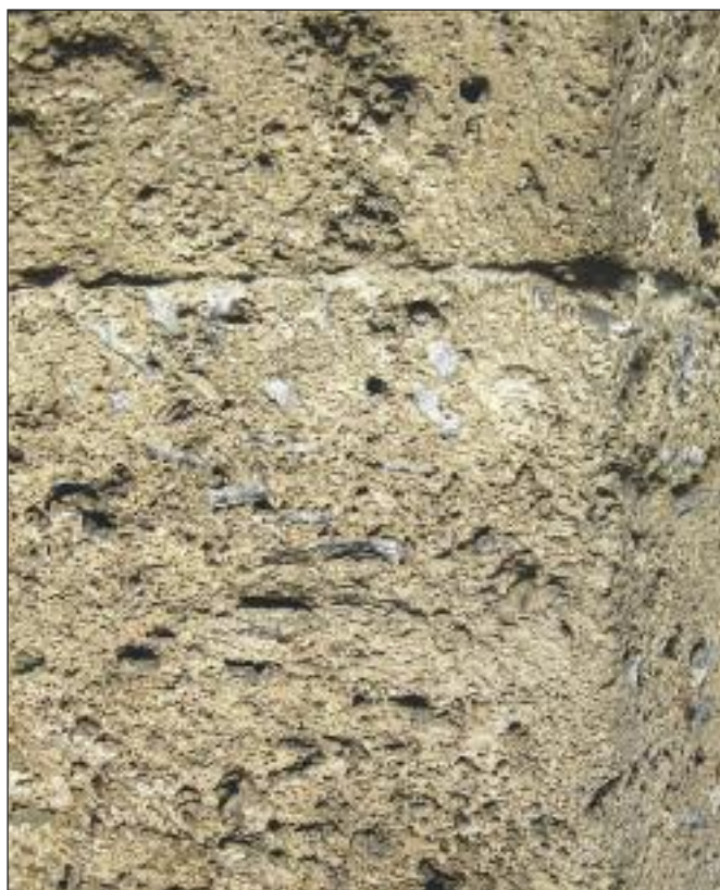
Fig. 27 - Segment de pilier en tuf, église Notre-Dame de la Visitation.
