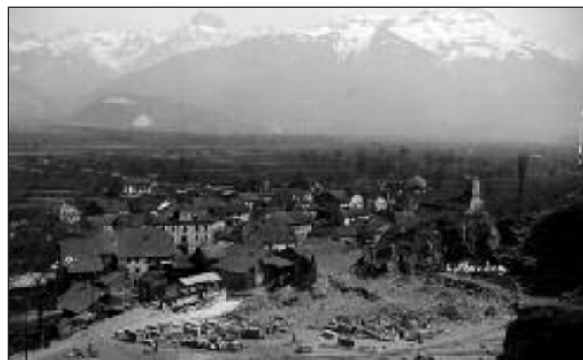
Fig. 22 - Carrière de La Croire à Collombey, vers 1925.
