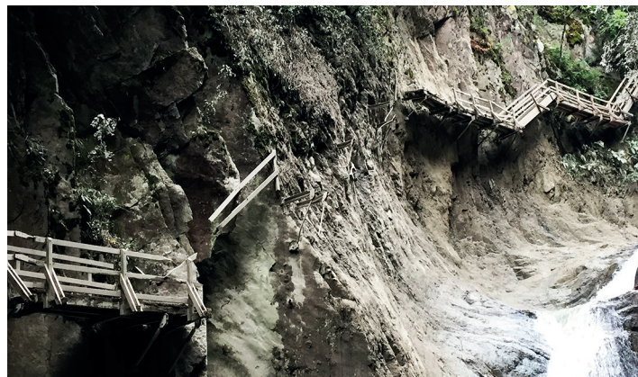
▲ En 1991 (photo du bas © Edgar Rebord), une crue emporte les passerelles construites trois ans plus tôt au-dessus de l'ancien tracé (photo du haut © Hugues Sarrasin).
