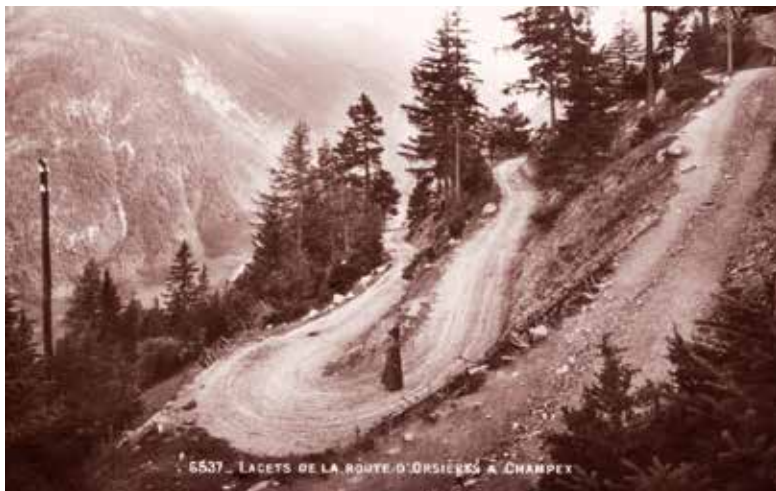
▲ Lacet de la route construite vers 1900 (flèche sur la carte), entre Chez-Les-Reuses et Champex, côtoyant l'ancien chemin.
