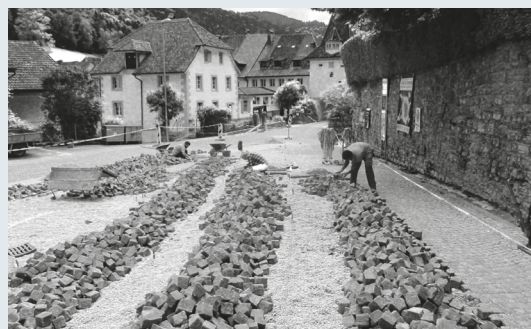
Les travaux de pavage ont été très conséquents. (Photo: Buchs & Plumey SA)
