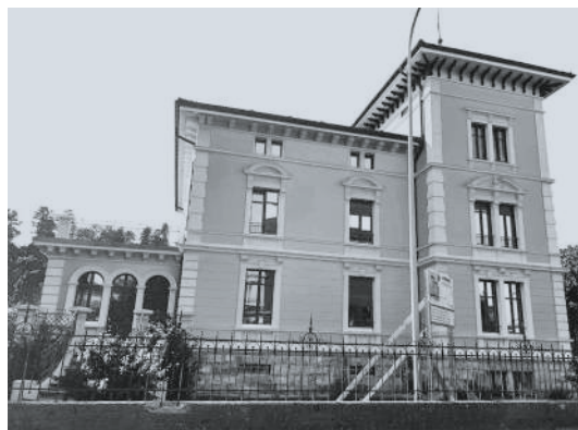
La maison après la rénovation des façades, le 18 mai 2022.
