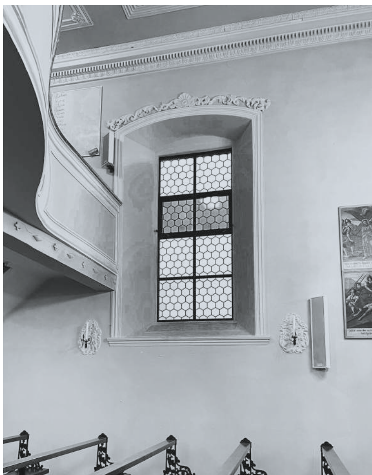
La fenêtre « test », en septembre.
