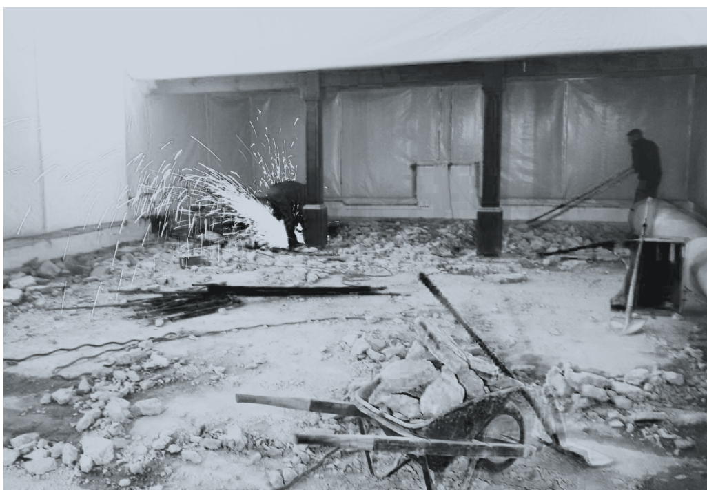
Le sol de la chapelle entièrement déposé, en octobre 2020.
