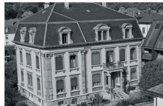
Les façades et la toiture de la maison après les travaux, en octobre. (Photo : Raymonde Gigon)
