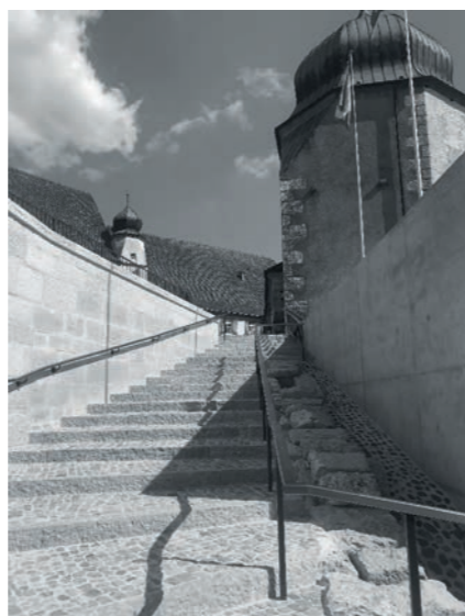
Le chemin d'accès piétonnier au château de Porrentruy réhabilité.
