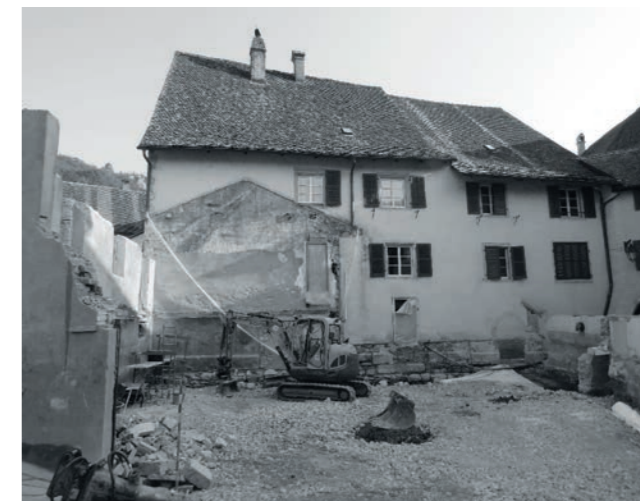
Les travaux de la future nouvelle place, en septembre.
