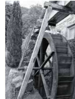
Soubey, l'eau coule à nouveau sur la roue du moulin. (Photo : Jean-Jacques Dünki, Soubey)
