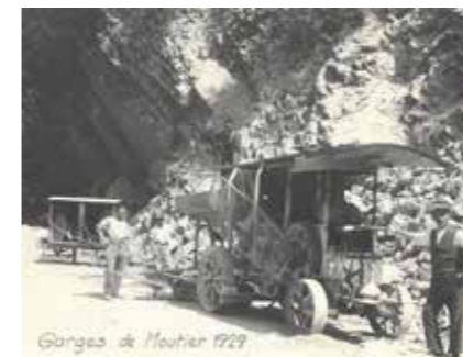
Travaux d'aménagements de la route des gorges de Moutier, 1929. ArCJ, fonds entreprise Friedli, en cours d'inventaire.
