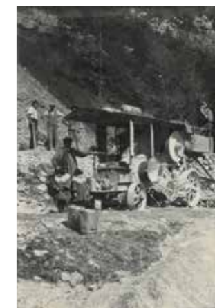
Octobre 1925. Louis Friedli, avec deux de ses enfants, ses quatre ouvriers, et le concasseur Jacquemai qu'il vient d'acquérir. Concassage à Nunningen (SO). ArCJ, fonds entreprise Friedli, en cours d'inventaire.
