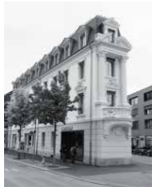
Delémont, Place de la Gare 2, après transformation intérieure et rénovation extérieure.
