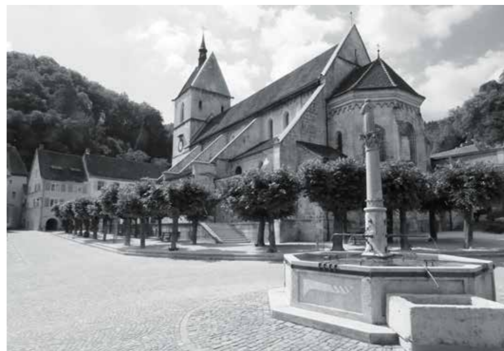
Clos du Doubs, Saint-Ursanne, la collégiale, la place et la fontaine du Mai, après réfection des revêtements de surface.
