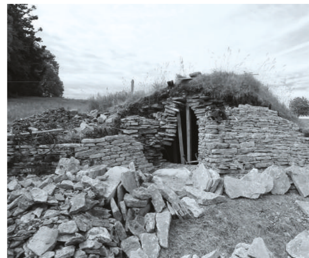
Epiquerez, citerne n° 1 du Clos des Citernes, en cours de restauration.
