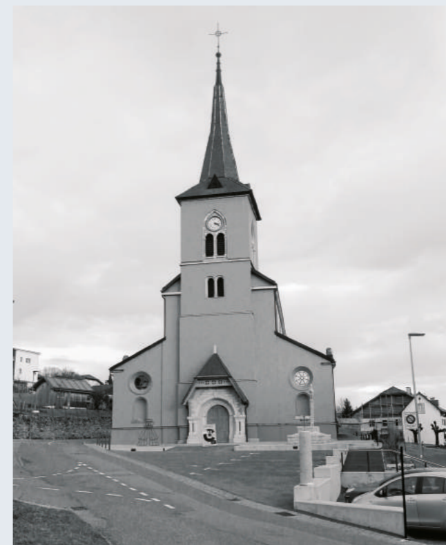
L'ancienne église au terme des travaux, après réfection du revêtement du clocher et de la façade ouest.
