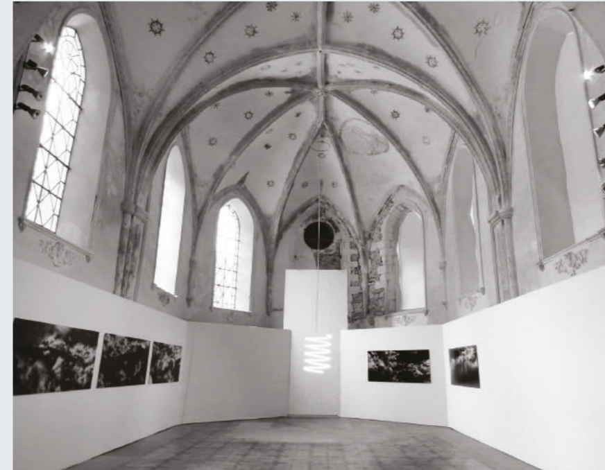
Le chœur de l'église, après les travaux de conservation.
