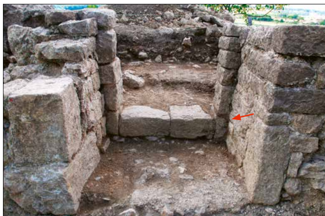
Abb. 88. Übersicht über die Eingangssituation MR 5. Blick nach Norden. Der Eingangsbereich ist im Vergleich zum restlichen Mauerwerk auffällig sorgfältig gemauert und ist nicht verputzt. Die Türzarge wurde an die Nordseite (=Aussenseite) angesetzt. Hinter (=südlich) der rechten (=östlichen) Türzarge hat sich ein letzter Rest des eisernen Türbandes erhalten (roter Pfeil).
