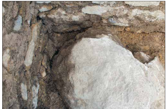
Abb. 86. Detailaufnahme der Südwestecke des Halbkellers. MR 2 und MR 3 wurden teilweise auf dem Felsblock errichtet. Allfällige Lücken wurden mit Kalkmörtel respektive Wandverputz geschlossen.
