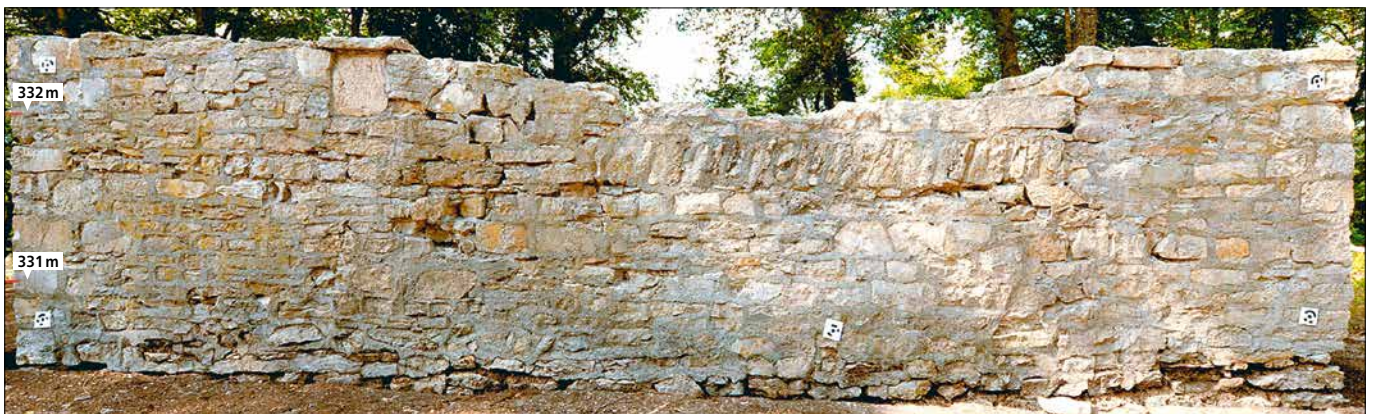
Abb. 143. Ansicht der äusseren Schale der Südmauer des valentinianischen Wachturms in Koblenz, Kleiner Lauf (AG). Das Mauerwerk besteht aus verschieden grossen Kalkbruchsteinen, die nur unregelmässig lagenhaft geschichtet sind.
