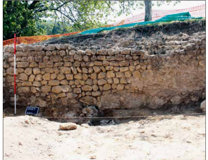
Abb. 82. Ansicht auf MR 3, Blick nach Süden. Die nur unregelmässig lagenhaft geschichteten, grob zugehauenen Kalkbruchsteine wurden vom Wandverputz in pietra rasa -Technik mit horizontalem Fugenstrich verdeckt, der sich nur im westlichen Bereich erhalten hat. Die grossen Steinblöcke am Fuss der Mauer fungieren als Fundament. Im Südwestecken (rechts im Bild) befindet sich der grosse, in den Raum ragende Felsblock.
