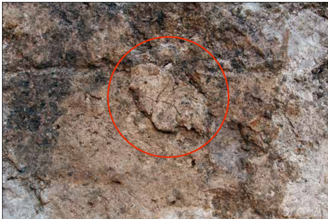
Abb. 83. Detailaufnahme der Westmauer (MR 2). Rot umrandet ist die zweite Lage des Wandverputzes. Entweder es handelt sich dabei um eine Erneuerung des Wandverputzes, bei der die ältere Schicht einfach überdeckt wurde, oder es handelt sich bei der unteren Schicht um die Grundierung («Arricio») für den sichtbaren Verputz («Intonaco»).
