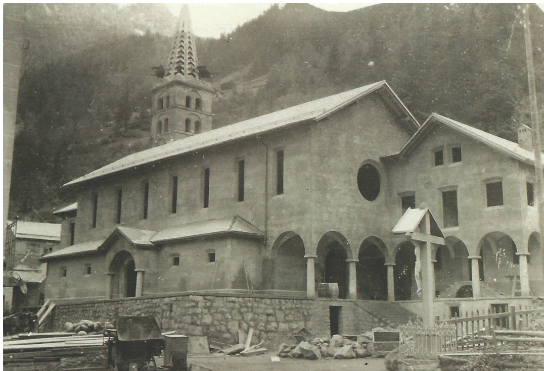
annexe 72. Église Notre-Dame de l'Assomption, Finhaut, 1928-1929. Église paroissiale de Finhaut : restauration 2004-2005 , [réalisation : Paroisse de Finhaut] ; [coord. : Sandro Benedetti, Christophe Lugon-Moulin], [Finhaut], cop. 2006, p. 13, 35.
