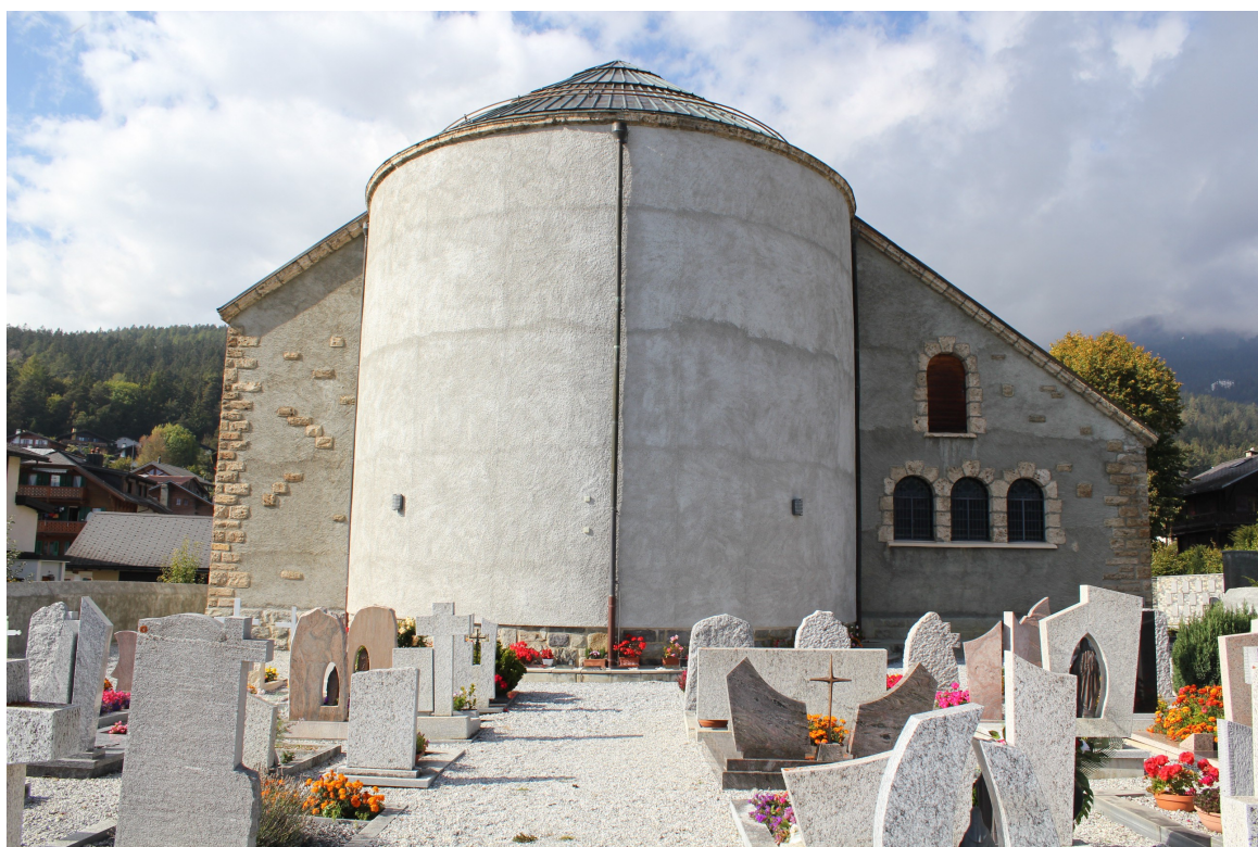
annexe 46. Église paroissiale Saint-Grat, Montana-Village, 1939, chœur. Photographie : Aude Devanthery
