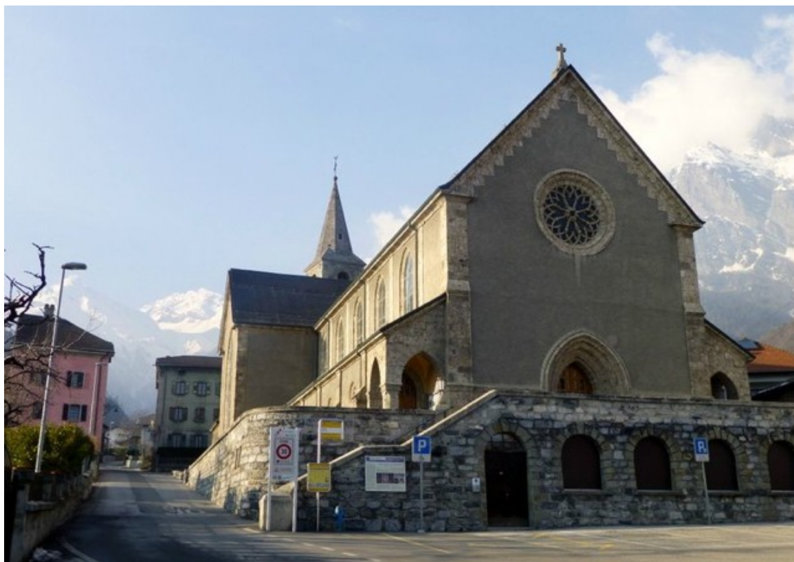
annexe 16. Église paroissiale Saint-André, Chamoson, 1927-1930, vue extérieure. http://mjethil.canalblog.com/archives/2013/02/19/26346848.html , consulté le 11.06.2015.
