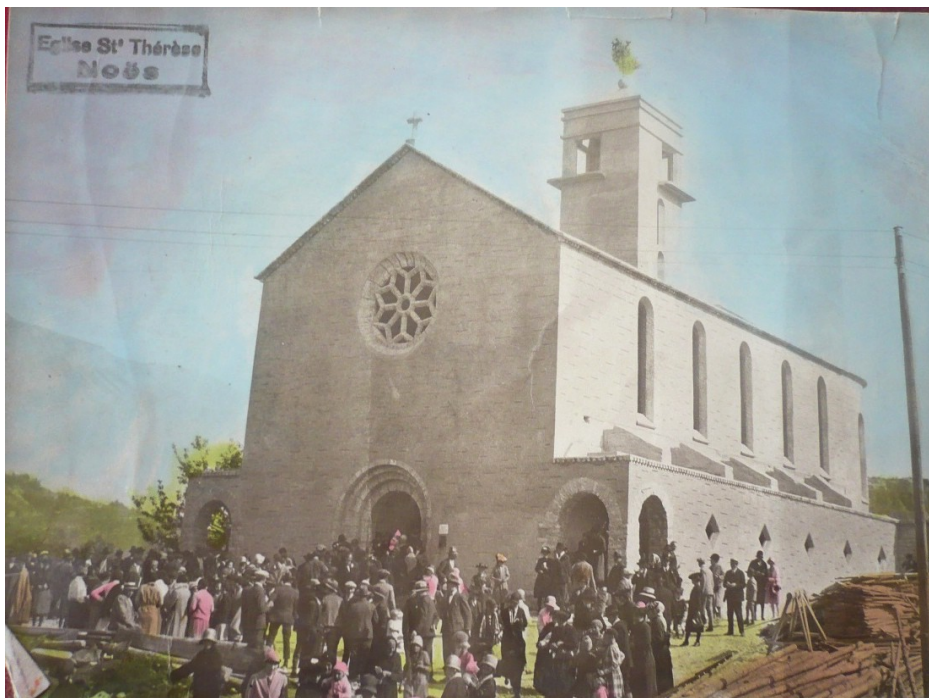
annexe 27. Église Sainte-Thérèse, Noës, 1928-1931, photographie colorisée non datée (vraisemblablement des années 1930). Atelier Saint-Dismas SA, Église Sainte-Thérèse de Lisieux de Noës : rapport investigations ; sondages et examens diagnostiques , 2015, p. 4.
