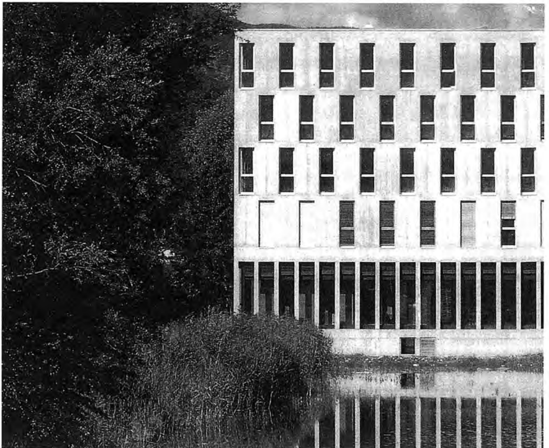
Administrationsgebäude werkhof A9 Brig
