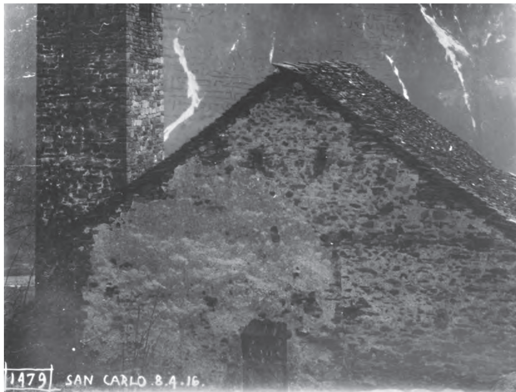
14. Prugiasco-Negrentino, chiesa di Sant'Amrogio vecchio. Particolare della facciata occidentale prima del restauro, 1916 (fotografia conservata all'AUBC)
