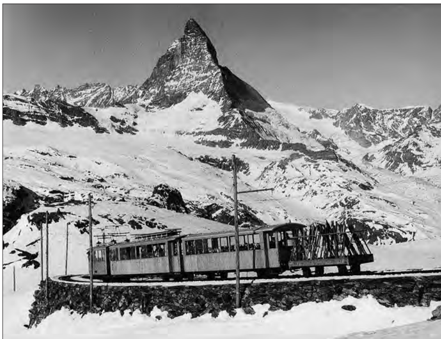
Abb. 20: Gornergratbahn auf dem obersten Streckenabschnitt, den sie seit 1942 auch im Winter befuhrt
