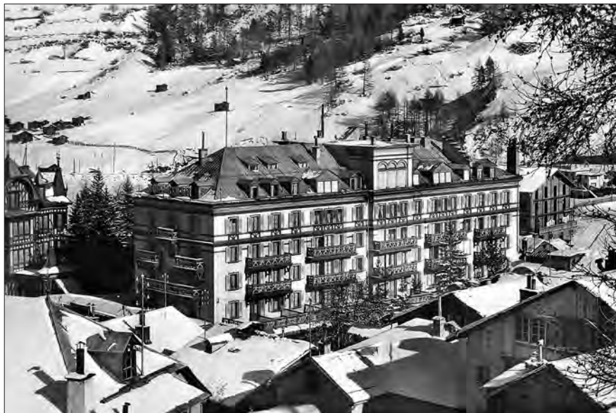
Abb. 19: Hotel Mont Cervin nach dem Umbau 1891–1893
