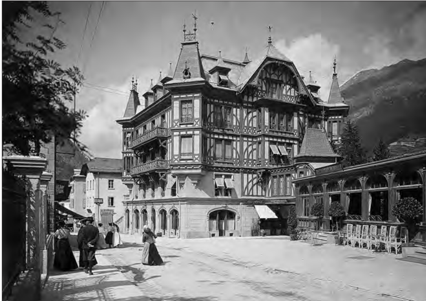
Abb. 22: Villa Margherita, 1902 eröffnet als Dependance zum Hotel Mont Cervin sowie als neues Postgebäude, entworfen vom Lausanner Architekten Louis Bezenenet
