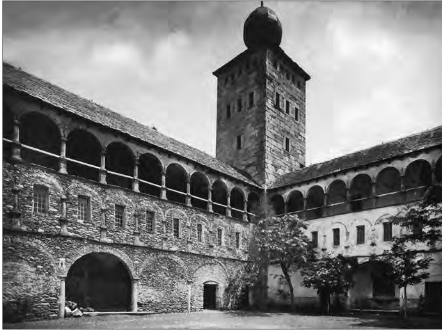
Abb. 6: Zugemauerte Arkaden im Stockalperhof
