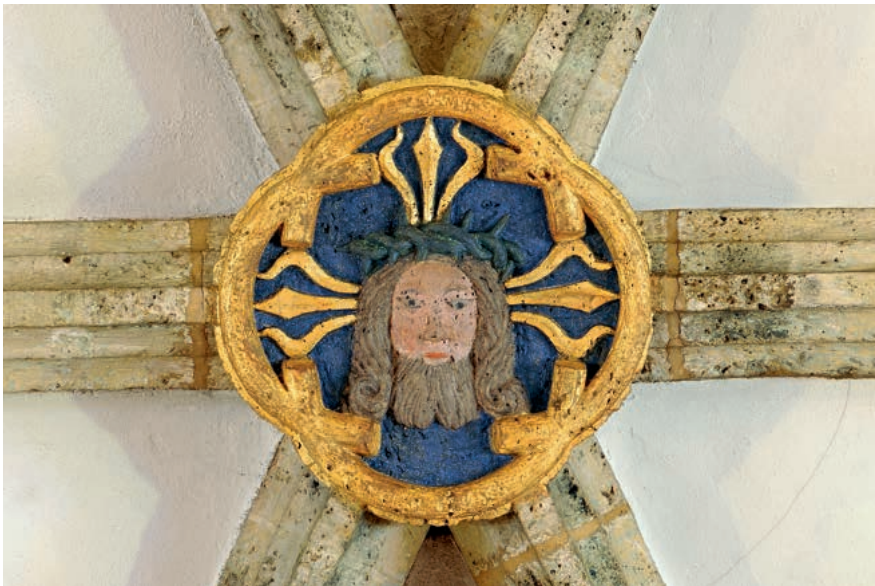
Abb. 27: Savièse, Saint Germain, Schlussstein am Schiffsgewölbe, La Sainte Face
