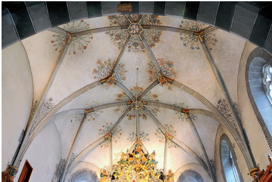
Abb. 21: Ernen, Sankt Georg, Chorraum mit spätgotischem Sternengewölbe
