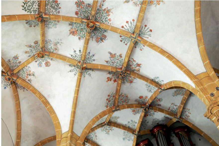
Abb. 20: Raron, Burgkirche, Mittelschiff mit spätgotischem Netzgewölbe
