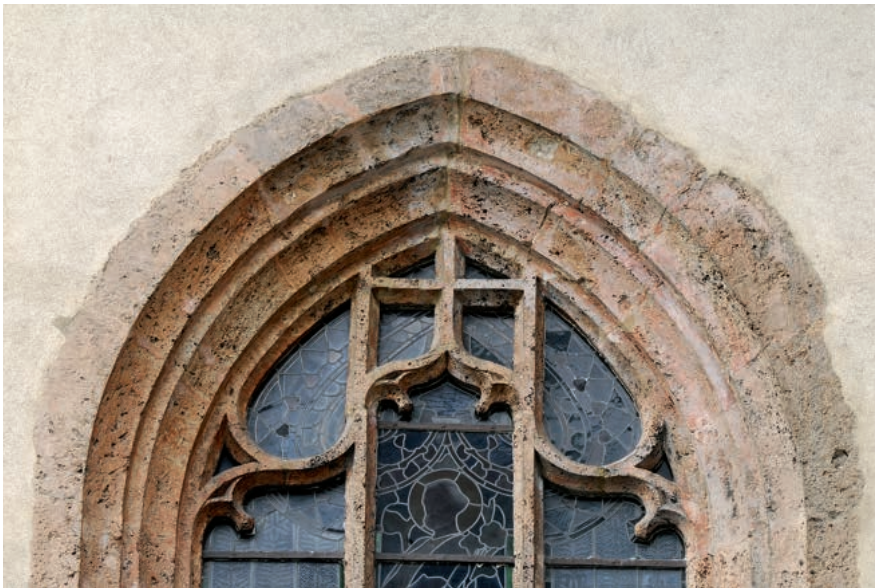
Abb. 17: Glis, Kirche Unsere Liebe Frau, Masswerk des nördlichen Chorfensters mit Ruffiners Meisterzeichen
