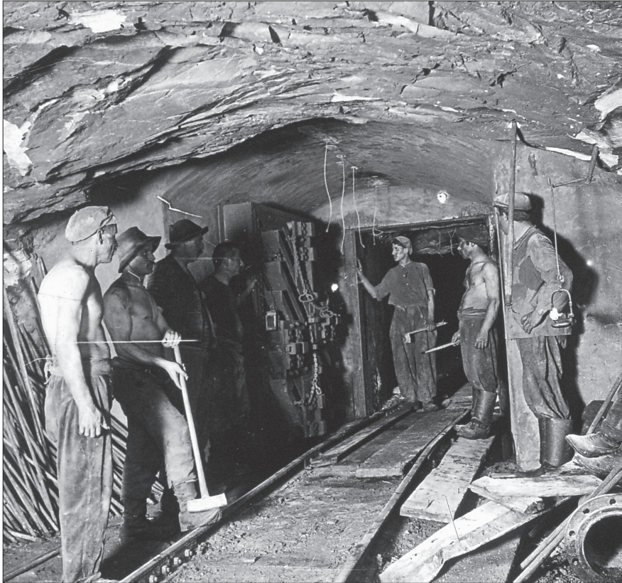
Abb. 1: Italienische Bauarbeiter im Simplontunnel
