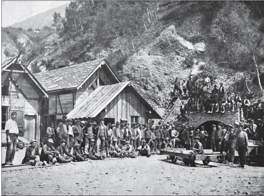
Abb. 2: Tunnelarbeiter vor dem Richtstollen
