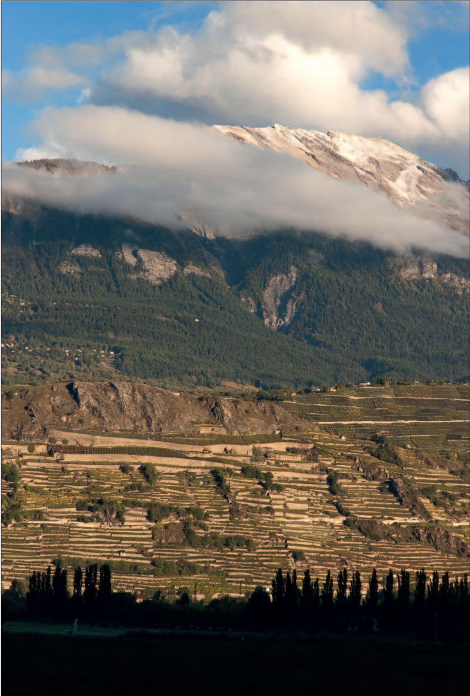
Le vignoble en terrasses de Clavau (Sion), avec, en haut, les murs impressionnants édifés par Antoine Michel Bonvin, dans la deuxième moitié du XIX e siècle. (Photo: Robert Hofer)
