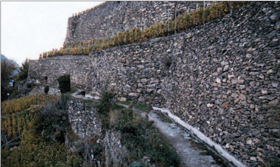
Murs de vignes le long du bisse de Clavau, vers 1970.
