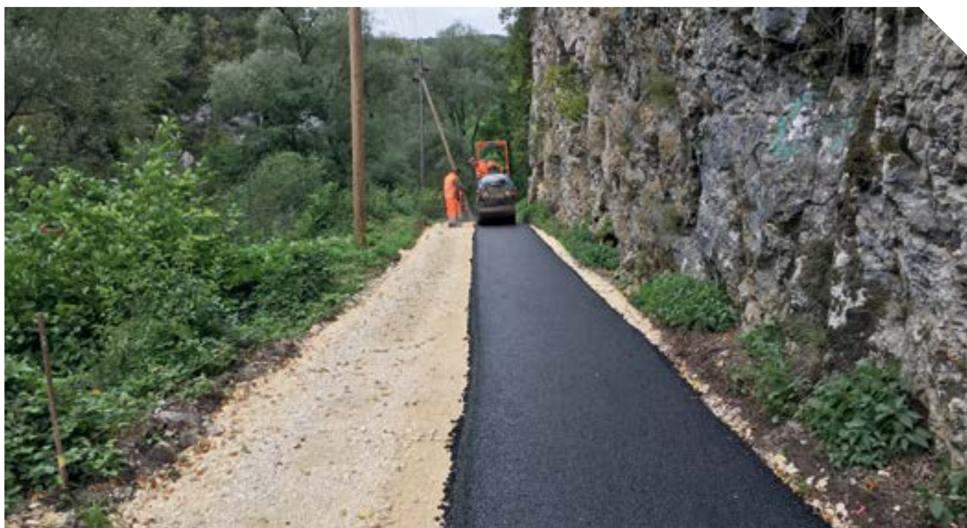
Travaux en cours pour l'itinéraire cyclable qui reliera Delémont et Soghières.
