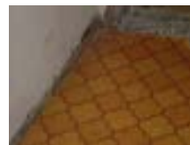
Revêtement de sol.
