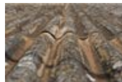
Toiture ondulée fibrociment.
