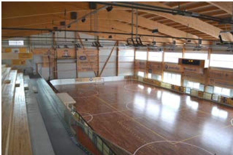
Doté d'une structure porteuse en bois et de façades métalliques, l'édifice à deux pans de 42 m sur 35 m s'articule autour de la surface de jeu de 800 m<sup>2</sup> dont le parquet en merbau est tout à la fois souple et très résistant. Du haut des gradins en bois pouvant accueillir entre 500 et 600 spectateurs, le public peut profiter d'une vue plongeante sur l'aire de jeu, qui est éclairée par des projecteurs LED et équipée d'une sonorisation performante.
