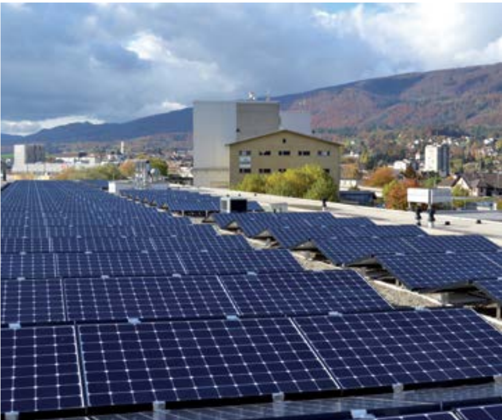
Chez Pressor, les 540 m 2 de panneaux photovoltaïques posés en toiture produiront 100'000 kWh d'électricité par an.
