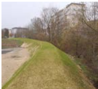
Digue derrière l'usine Schäublin
