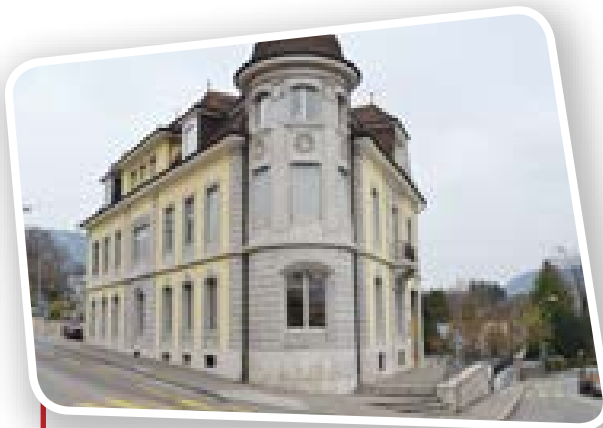
Le 11 avril 1940, l'assemblée communale vote un crédit de 130'000 francs pour l'achat du bâtiment à la route de Bâle pour les Services industriels et l'Ecole de commerce. L'inauguration aura lieu en mars de l'année suivante. Cet édifice néobaroque construit en 1910, avec tourelle d'angle arrondie, abrite actuellement l'administration des SID (jusqu'en 2017) et le Service UETP.
