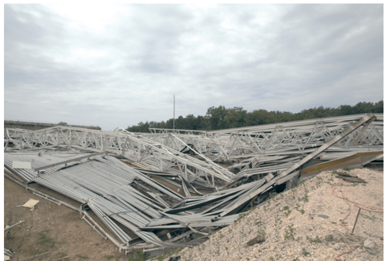
La structure en acier de 2'200 tonnes s'est ouverte comme prévu vers l'est et affaissée de manière contrôlée.
