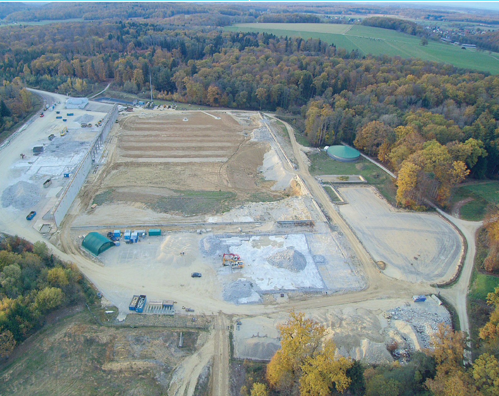
Vue aérienne depuis le sud sur le site en novembre 2017 : les trois halles ont disparu sauf le mur à gauche. L'ancienne décharge est remblayée. La plupart des installations sont démontées.
