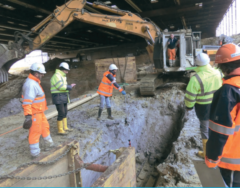
La construction du drainage qui permet de capter l'eau de la lentille sableuse au nord.
