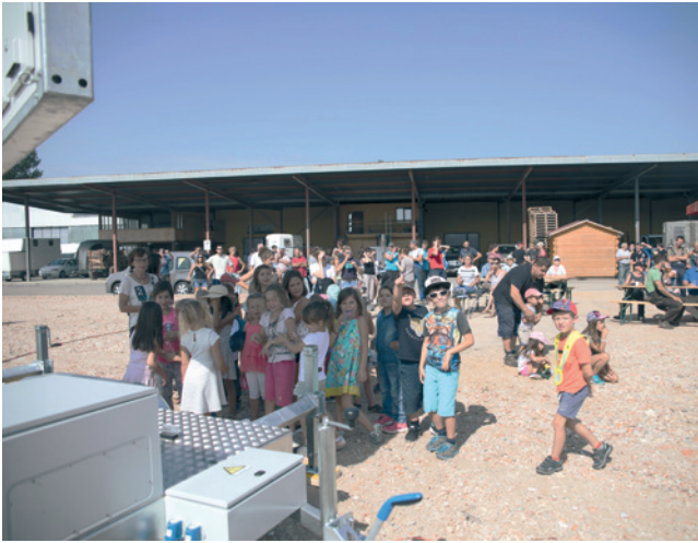
De nombreux riverains ainsi que la classe primaire de Bonfol suivent le minage sous différents angles, sur le grand écran installé dans le technoparc Cisa SA.
