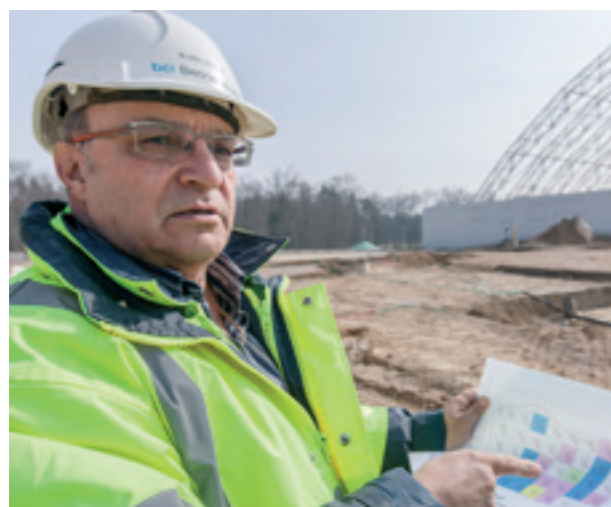
Selon les résultats des sondages, le directeur de chantier, Alain Lachat, a fait décaper le couvercle de la partie nord.
