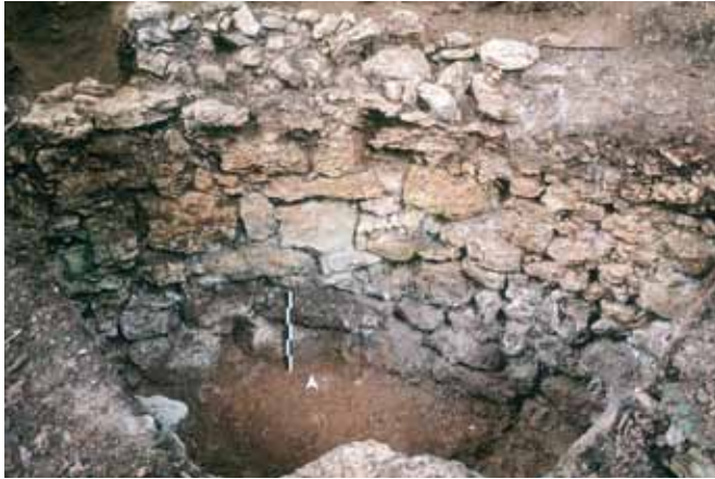
Fig. 113. Courtedoux-Bois de Montaigne. Vue du mur de soutènement de la voûte après évidement partiel. La cavité visible à sa base peut avoir servi à loger une poutre soutenant un cintre en bois, pour la construction de la voûte.
