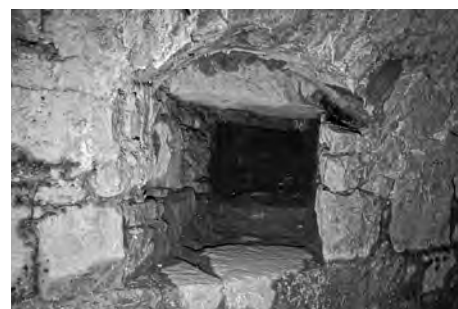
Fig. 54. Vue du linteau de la canalisation C1 à l'intérieur de la cave.
