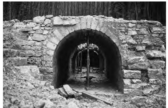
Fig. 28. Vue de l'entrée de la cave depuis l'extérieur ouest. On remarque le ressaut du côté nord de la voûte, vestige d'un ancien collecteur d'eau en fonction jusqu'à la phase 4.
