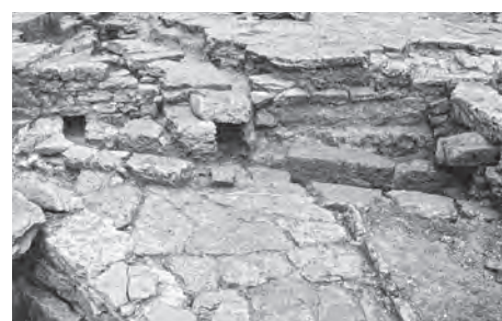
Fig. 62. Vue de la sortie de la canalisation C3 et entrée du carneau Ca1 sur la façade ouest.
