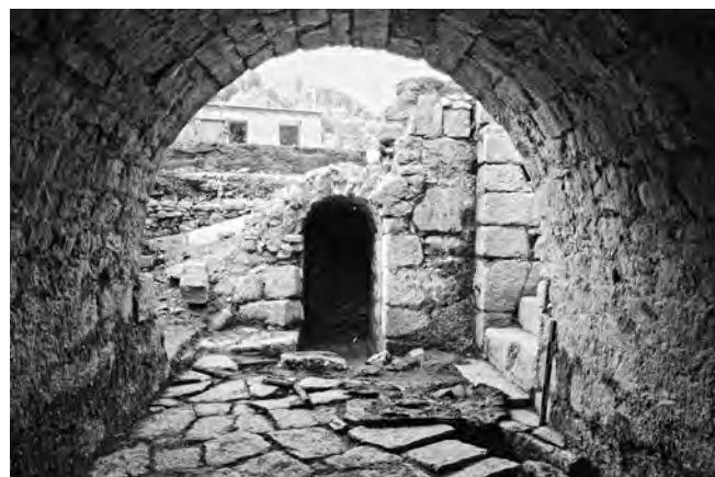
Fig. 39. Vue de l'entrée ouest de la cave depuis l'intérieur. La rigole C1, visible en bas à droite, se dirige vers la canalisation voûtée.
