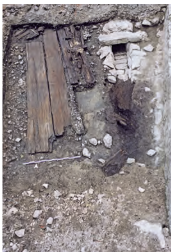
Fig. 120. Vue de la canalisation C6 dont l'extrémité sud a été recouverte de planches. Sur son côté ouest, tentative d'assainissement de la zone humide.
