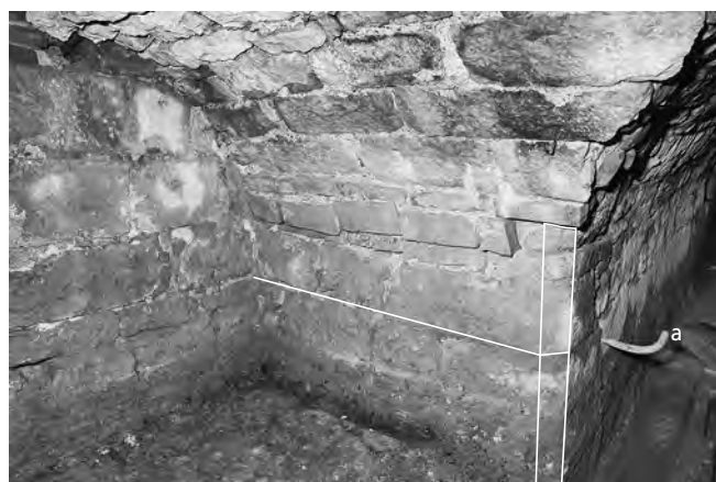
Fig. 25. Vue de la jonction entre la niche nord et la cave. Le chanfrein et le ressaut sur la paroi nord marquent la limite de la rubéfaction de la voûte (en blanc); a) crochet métallique.
