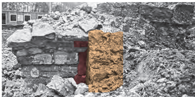
Fig. 41. Vue en coupe de la niche nord lors de la démolition. Le mur d'obturation est-ouest (en orange) vient s'appuyer contre les murs interrompus de la cave (en rouge).
