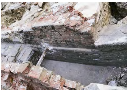
Fig. 114. Détail de l'enduit réfractaire couvrant la paroi interne de F65 au-dessus du cendrier.
