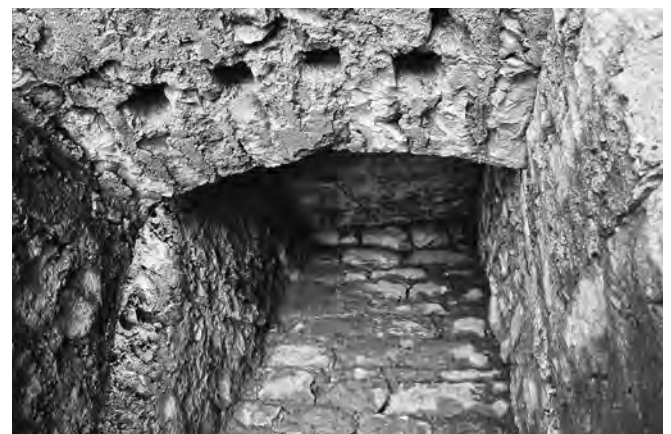
Fig. 30. Détail du linteau dans lequel s'insère la grille d'obturation de la claire-voie orientale.
