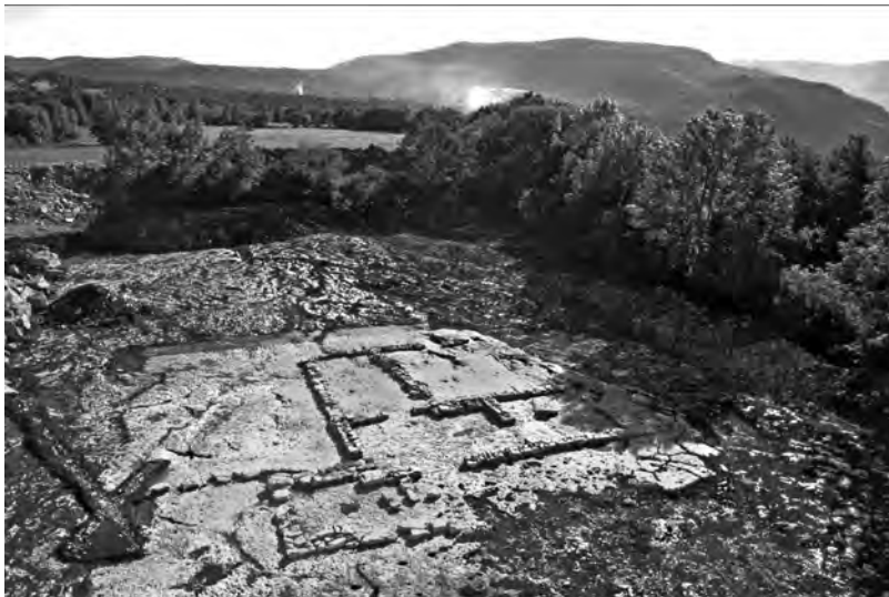
Fig. 4. Vue aérienne de l'édifice résidentiel de Pratz, Le Curtillet. (D Billoin - INRAP)
