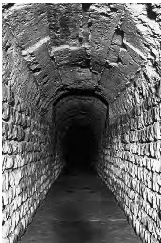
Fig. 19. Augst, canalisation d'évacuation dans l'emprise du théâtre; profil nord avec piédroits en maçonnerie ( opus vittatum ) et voûte montée sur un cintre de bois. (I. Horisberger-Matter - Römerstadt Augusta Raurica)
