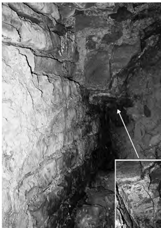
Fig. 17. Augst, pan de mur effondré du second théâtre à scène, avec les vestiges d'une arcade aveugle en grès revêtue d'un enduit; la trace de mortier en arc-de-cercle marque l'intrados de l'arc aveugle; au-dessous de l'arc, la maçonnerie de moellons calcaires formant le fond de l'arcade est décorée de joints marqués au fer et réhaussés de rouge. (I. Horisberger-Matter - Römerstadt Augusta Raurica)
