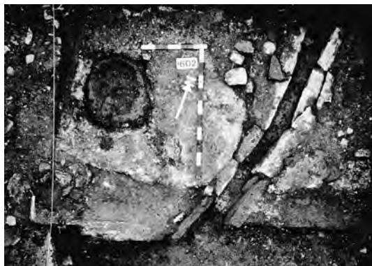
Fig. 11. Augst, chantier du second théâtre à scène; aire de gâchage du mortier avec petit canal d'évacuation en pierres calcaires. (I. Horisberger-Matter - Römerstadt Augusta Raurica)
