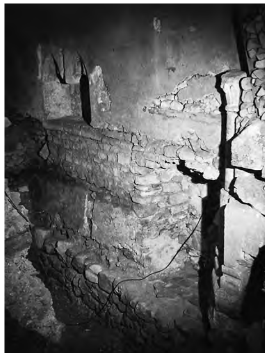
Fig. 6. Fouille du mur sud du chœur de l'église Saint-Pierre interrompu par une porte : mise au jour du pilastre. (C. Lapaire - Archives fédérales des monuments historiques, Berne)
