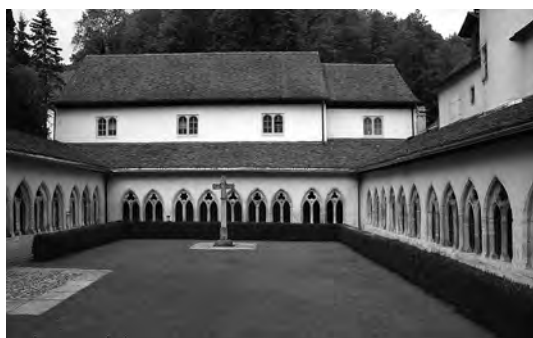
Fig. 13. Le cloître et l'église Saint-Pierre après leurs restaurations en 1982. (B. Migy - OCC/SAP)
