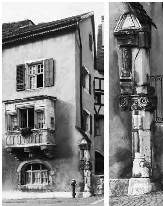
Fig. 7. Maison des Œuvres, Saint-Ursanne. Exemples d'éléments architecturaux réutilisés, notamment le chapeau d'inspiration ionique. (République et Canton du Jura, Office de la culture, Porrentruy)
