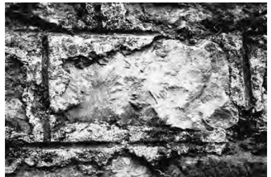
Fig. 18. Augst, second théâtre à scène. Vue de détail du traitement de surface en pseudo pietra rasa de la maçonnerie de pierres calcaires; les traces marquées au fer sur les joints sont peintes en rouge foncé. (I. Horisberger-Matter - Römerstadt Augusta Raurica)
