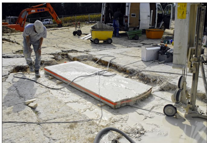
Fig. 129. Sciage horizontal d'un prélèvement avec un câble. Mise en place de cales pour soulever le prélèvement au fur et à mesure de l'avancée du câble.
