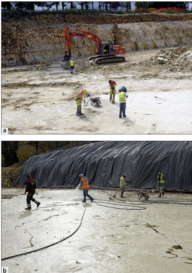
Fig. 57. Préparation de surfaces pour analyse: a) balayage; b) jet à pression.
