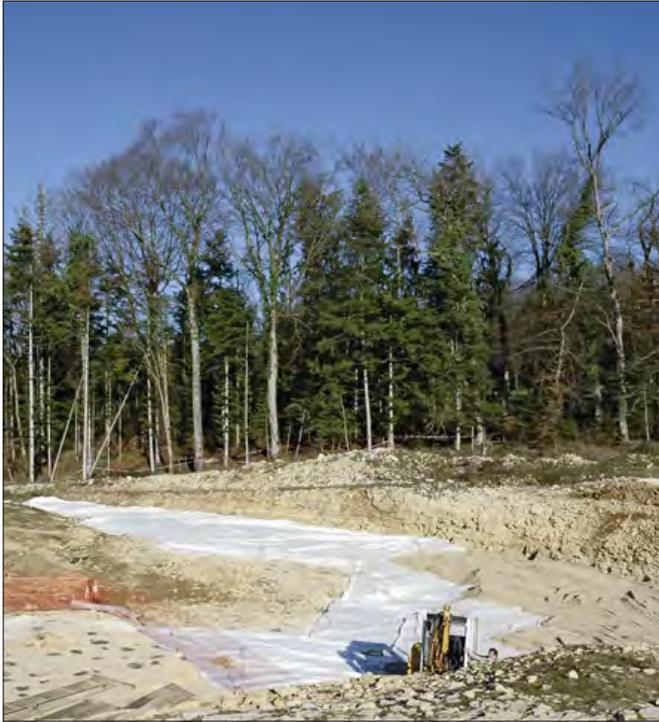
Fig. 10. Recouvrement du site, avec du sable et du géotextile, avant la construction de la bretelle autoroutière.
