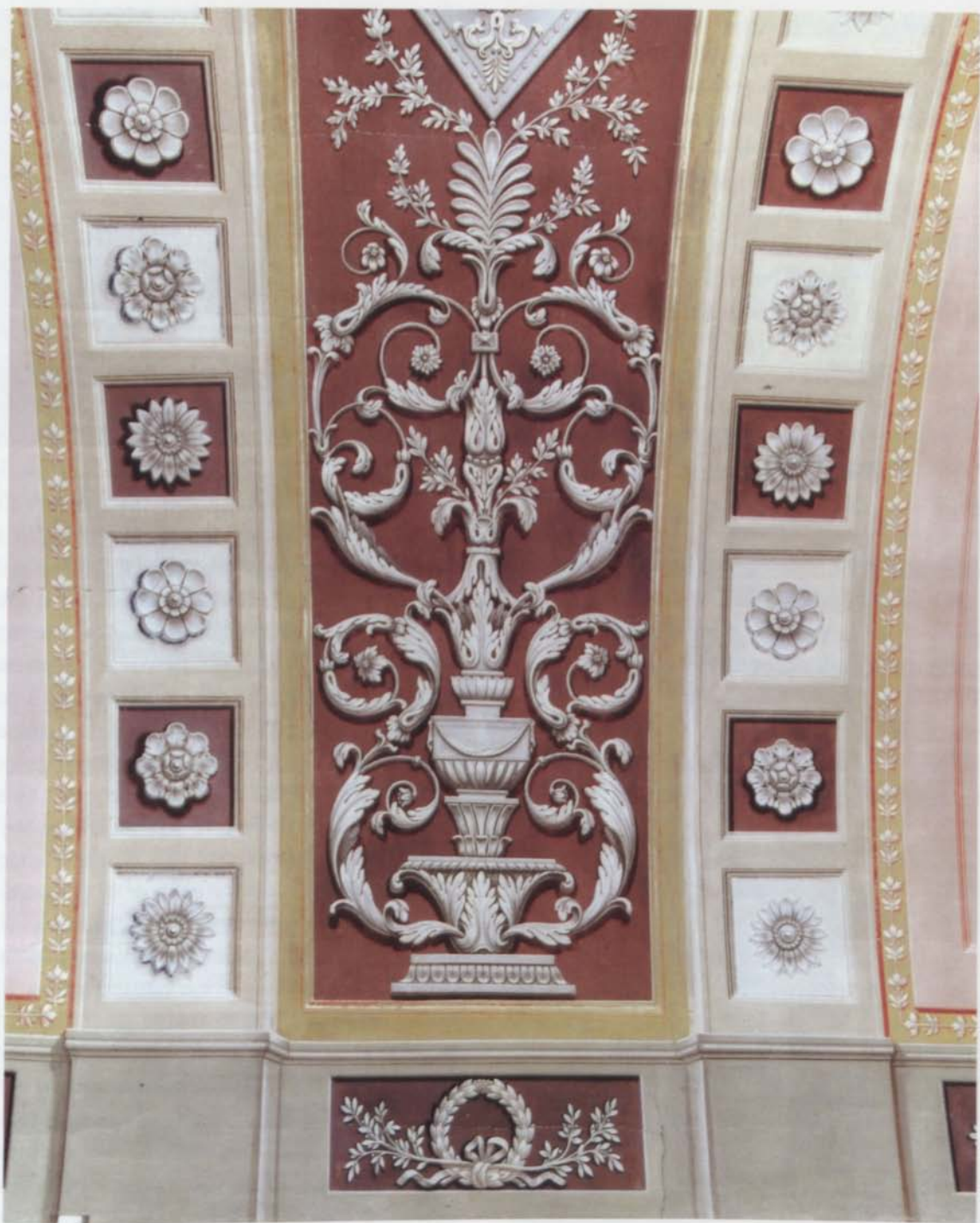
Détail du plafond de la galerie. Etat en 2002.
