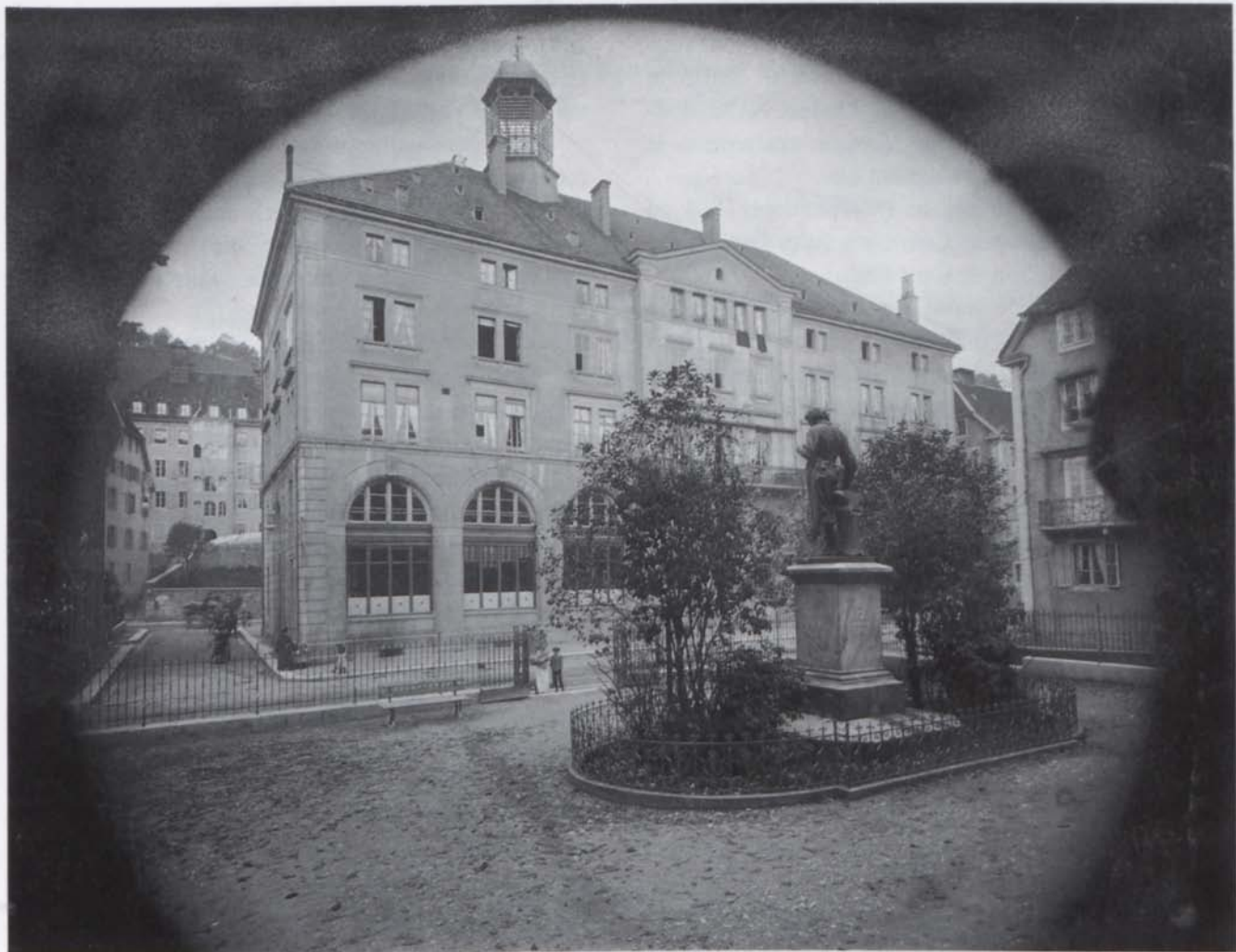
Hôtel des Postes, vers 1900 Musée des Moulins du Col-des-Roches
