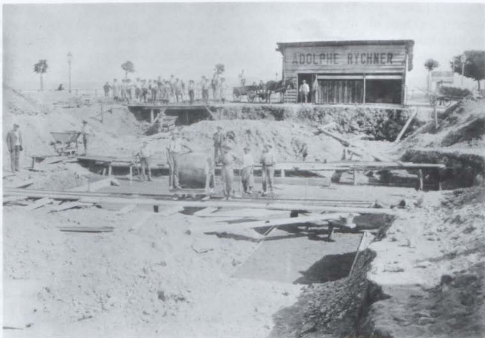
Neuchâtel, hôtel des Postes, travaux de terrassement
