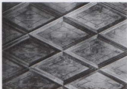
Plafond de la chambre de la Grande-Coronelle (photo A. Dellenbach, 1933).
