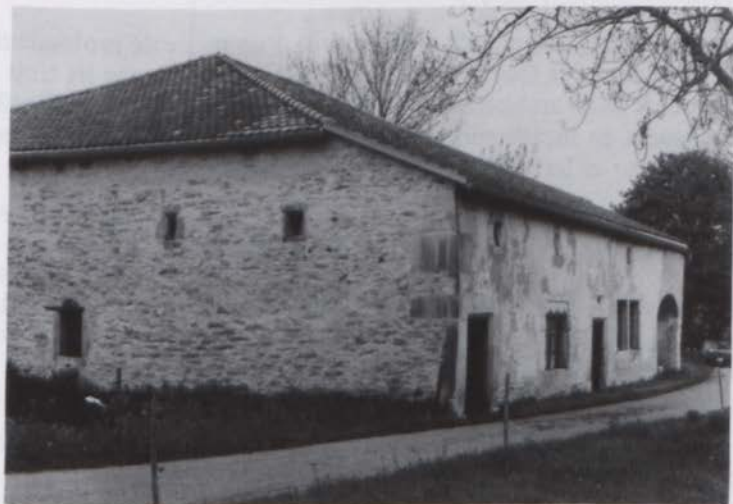
dite La Maison carrée!
