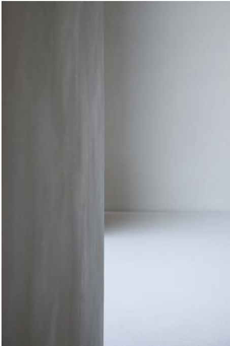
Abb. 7: Verputztes Ziegelmauerwerk (Foto: Markus Joachim)
