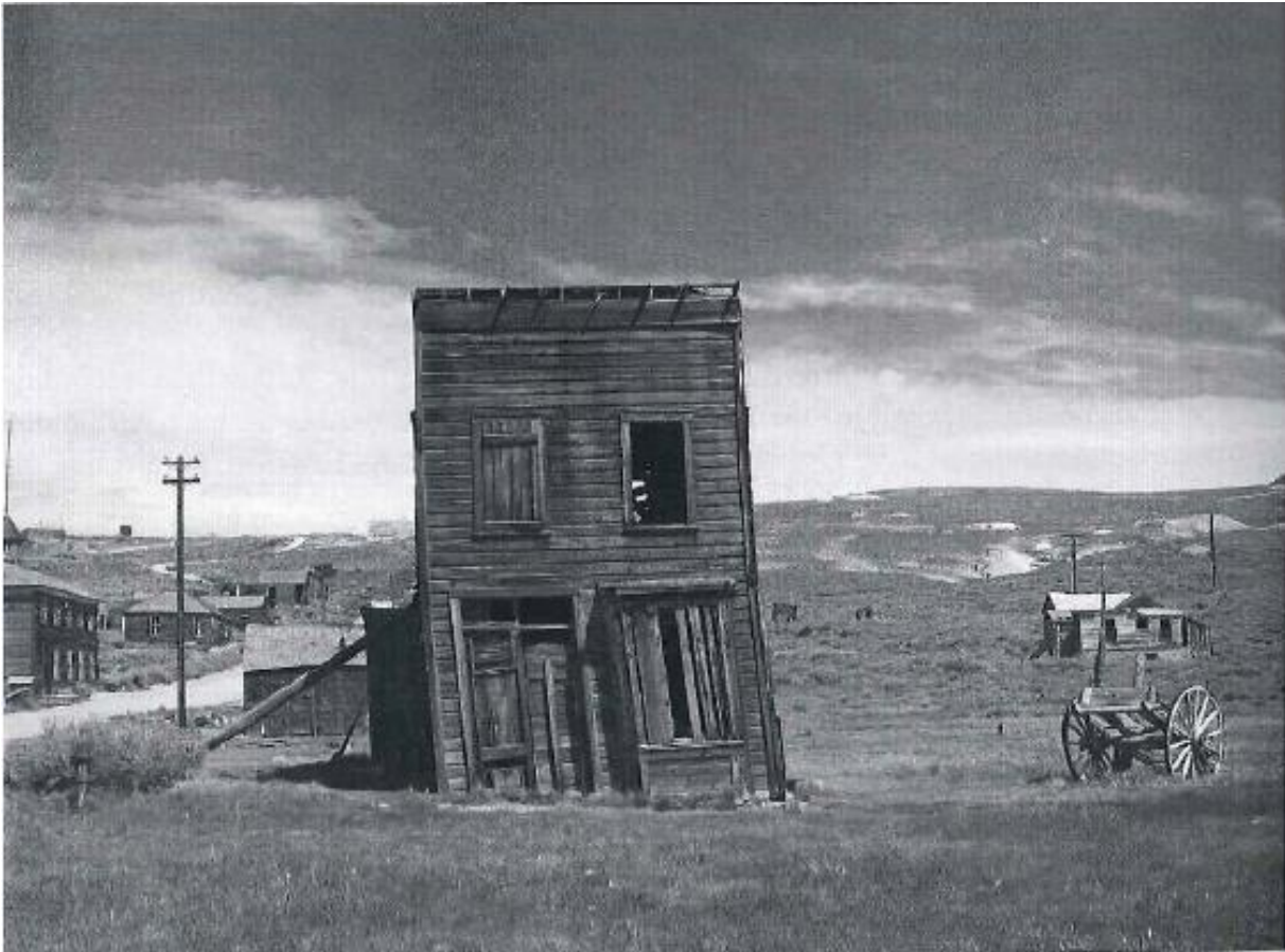
Abbildung 15: Altes Gebäude im Bodie State Historic Park, Kalifornien
