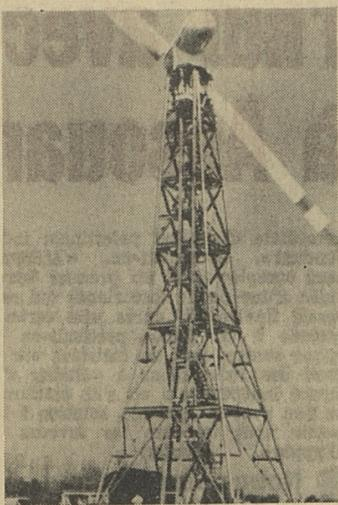
Moulin à vent des temps modernes. Production garantie : 100 kw-h pour un vent de 30 km-h. (Keystone)
