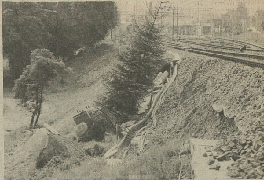
La ligne CFF entre Wetzikon et Pfäffikon a dû être fermée, les eaux ayant miné le remblais. (Keystone)
