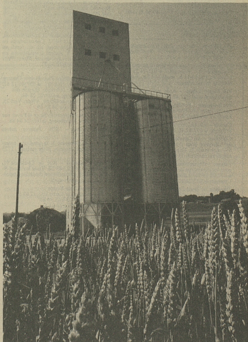
Les deux nouveaux silos du «Moulin-Neuf».
