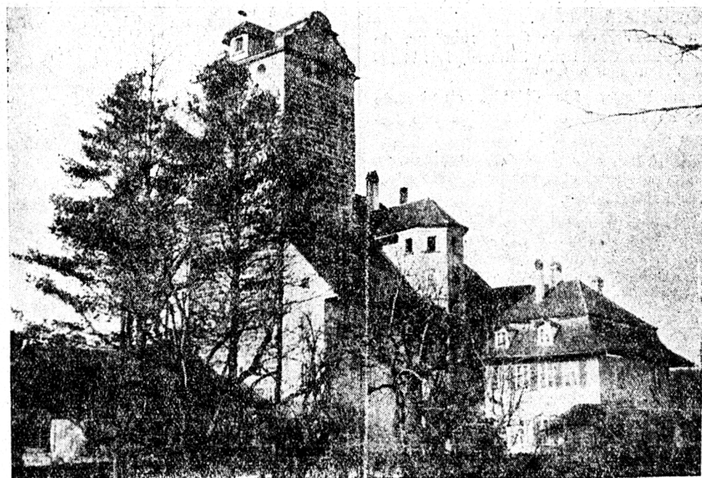
Le château d'Aarwangen (Berne), bâti au XIII ème siècle pour commander un passage de l'Aar; siège d'une seigneurie acquise par l'Etat de Berne en 1432, puis résidence baillivale. La tour, en blocs de tuf, a 32 mètres de hauteur.
