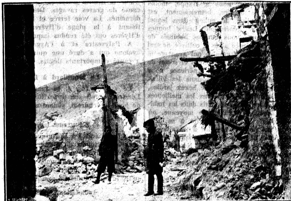
La petite ville de Lama de Pelicci, l'une des plus endommagées par le tremblement de terre des Abruzzes.
