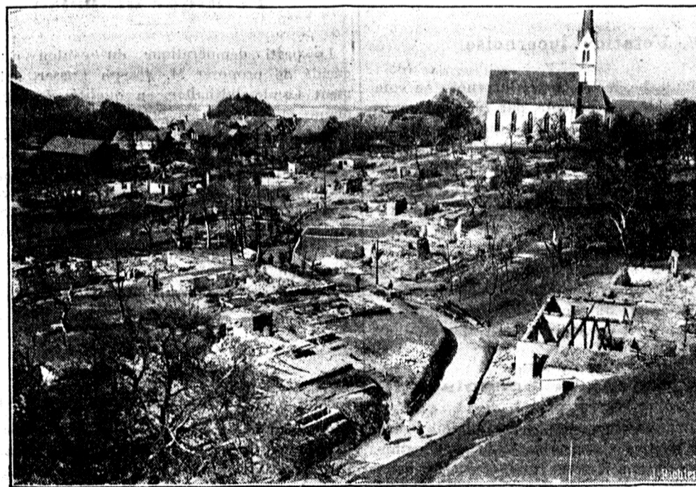
Le village de Fraxern, dans le district de Feldkirch, presque entièrement détruit par un incendie.
