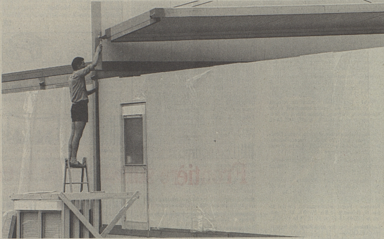
Se dépêcher de couvrir les pavillons avant la pluie...
