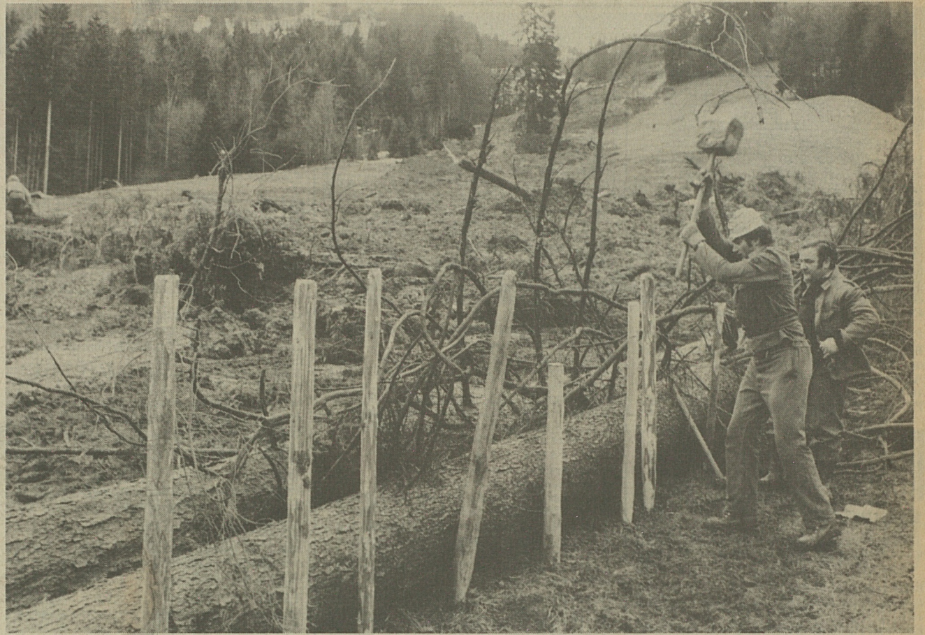
Les pompiers construisent une digue afin de protéger la ferme de M. Gremion
