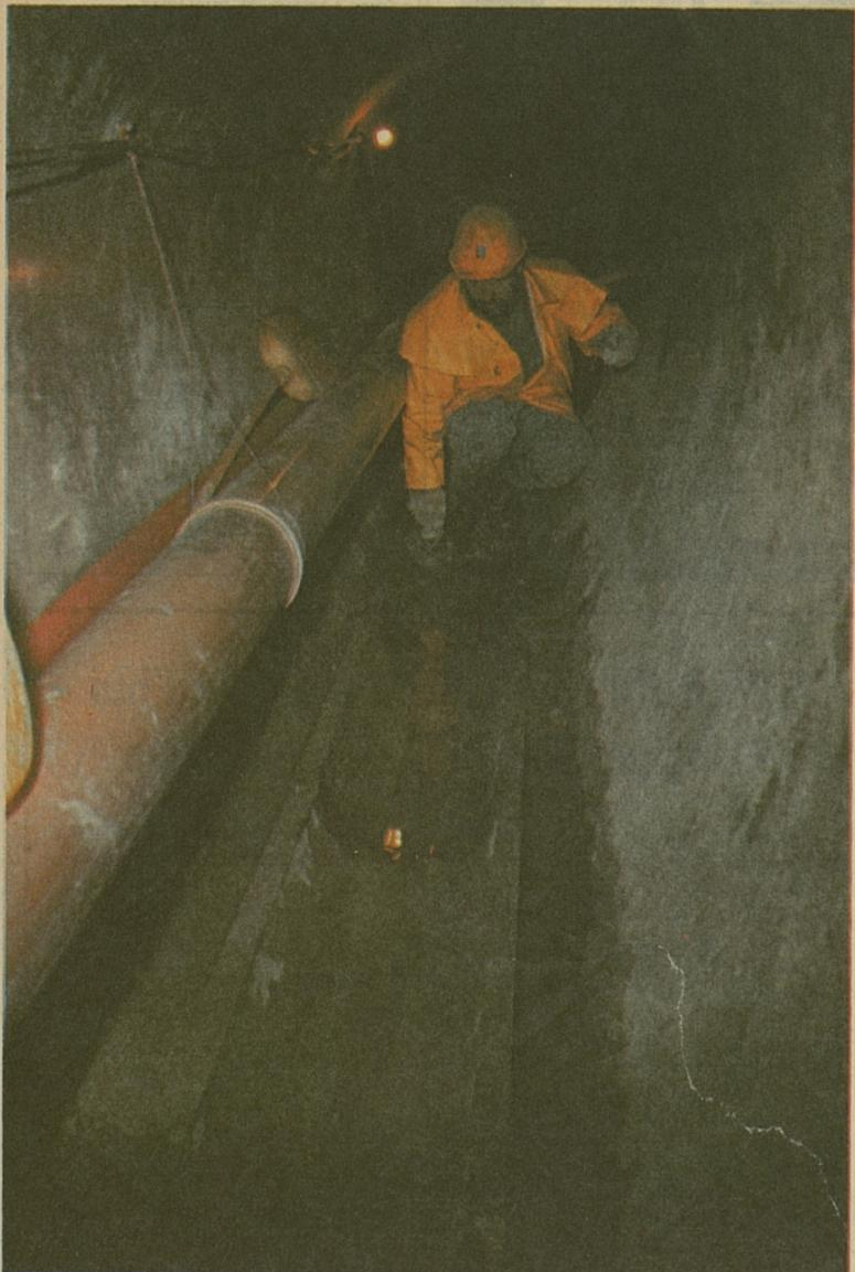
Pour pouvoir travailler au sec et remplacer proprement le radier dans le collecteur de la Neuveville, une conduite provisoire a été mise en place.
