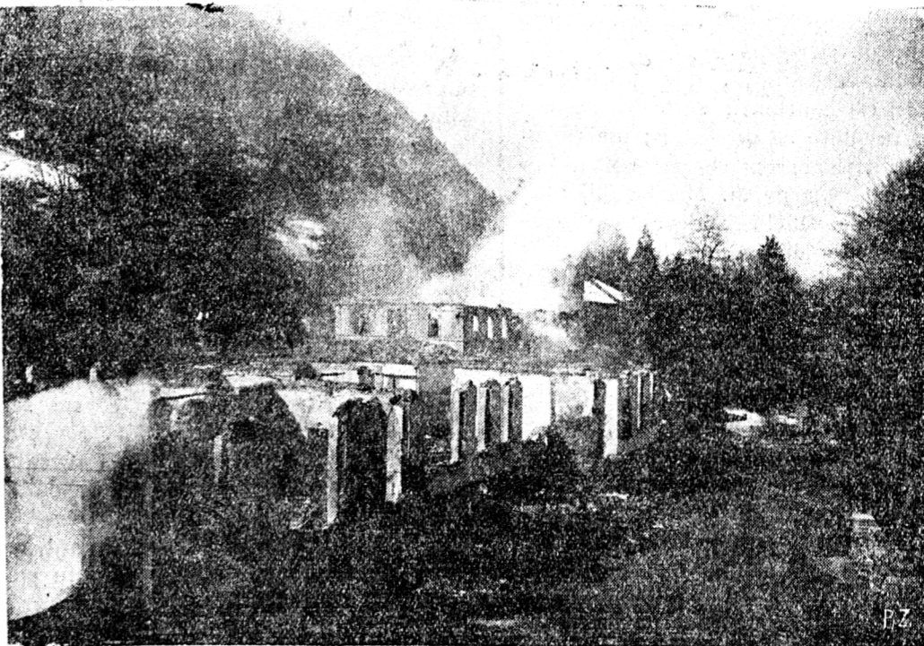
APRÈS L'INCENDIE, IL NE RESTE QUE LES MURS
