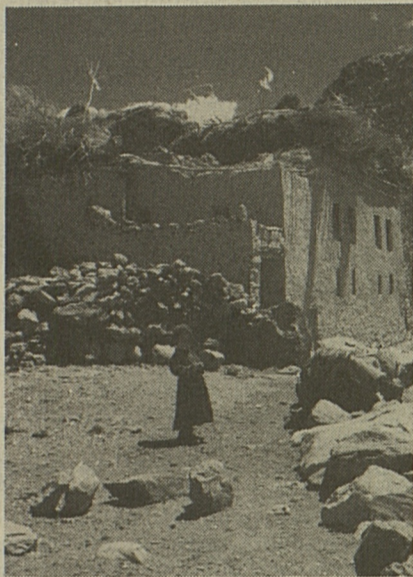
Des maisons de pierres et de briques de terre, blanchies à la chaux. On vous fait asseoir par terre.
