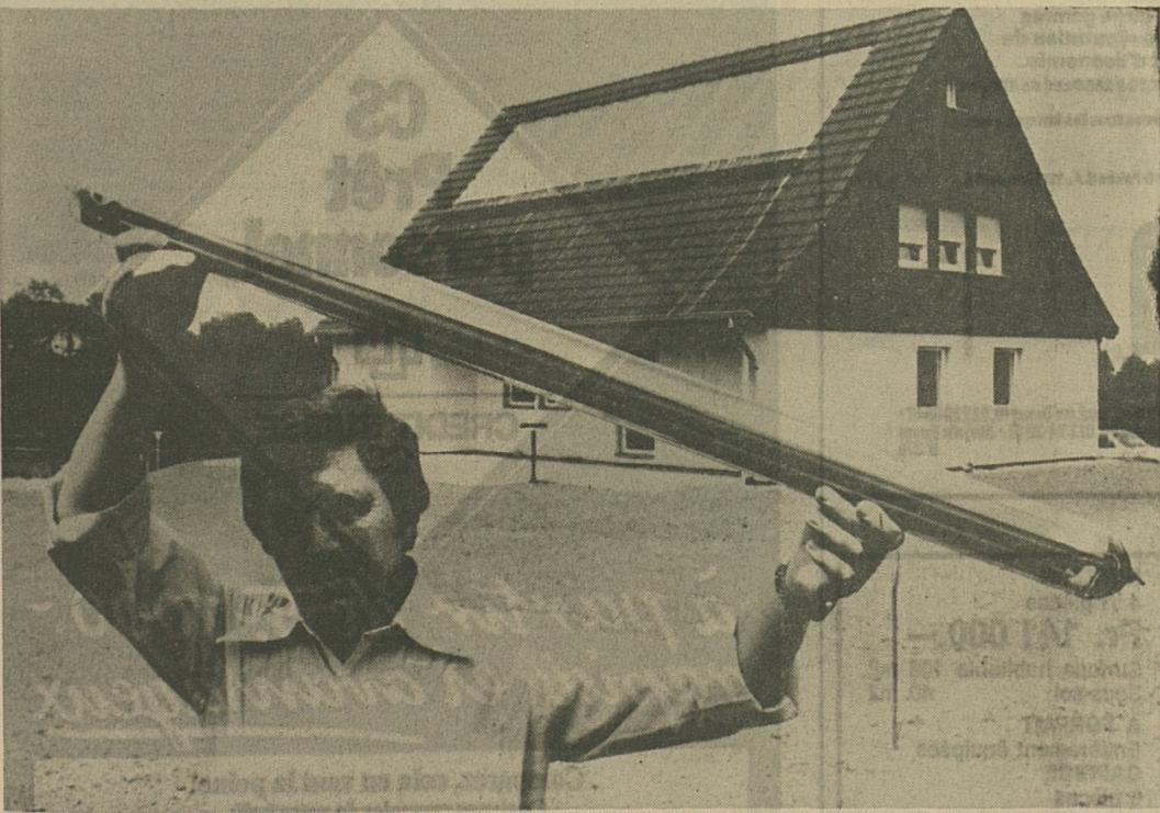
L'énergie solaire pour le chauffage domestique. Des collecteurs placés sur la toiture permettent d'abaisser considérablement la consommation de fuel pour le chauffage de l'eau. Au premier plan, une unité du collecteur.
