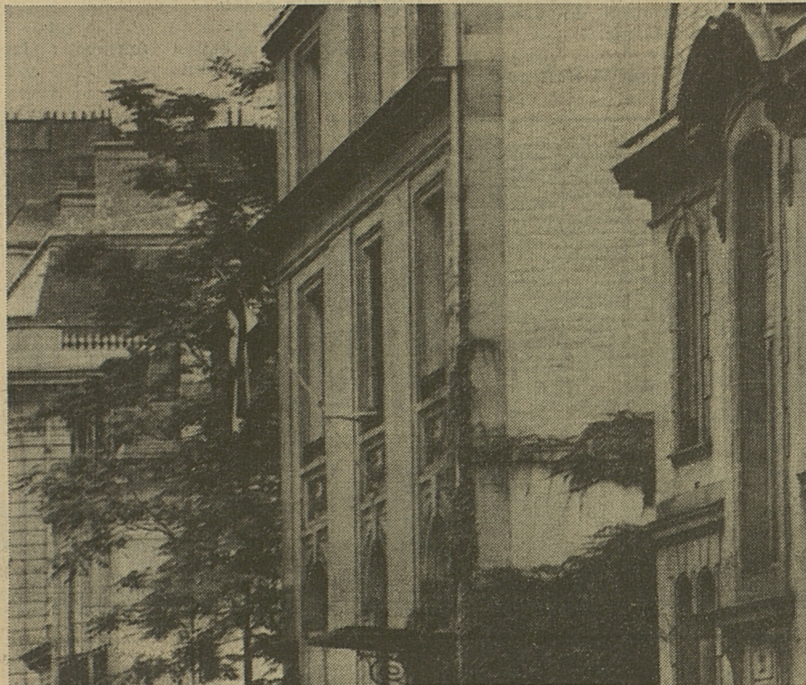
Le bâtiment de l'ambassade irakienne à Paris.
