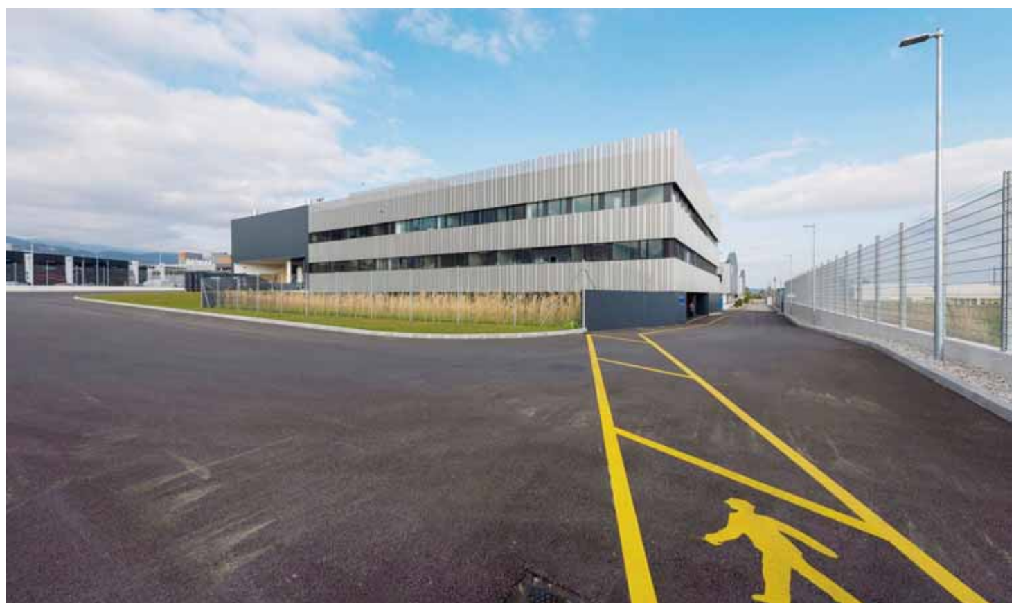
Complexe et très sécurisé, le nouveau bâtiment administratif et logistique de Metalor a été construit en deux ans. Cinq cents tonnes d'acier, hors structure, 200 portes (dont 120 coupe-feu) ou 3,5 km de conduites sous pression ont été nécessaires pour le réaliser. LUCAS VUITTEL
