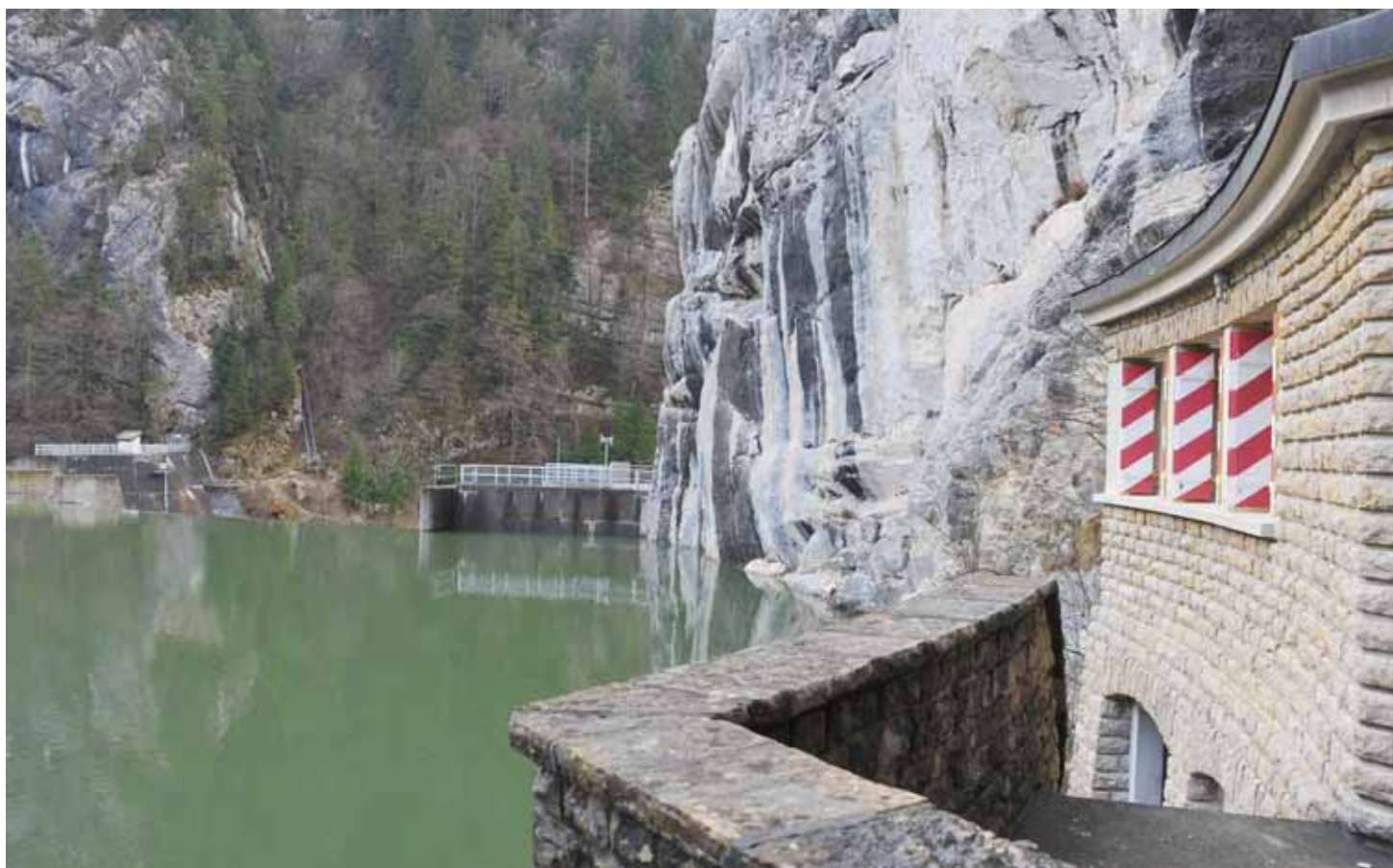
Le barrage du Châtelot a été mis en service en 1953 sur le Doubs franco-suisse. Si, dans les premières années, on se préoccupait peu de son impact sur la rivière et ses occupants, depuis, la société doit se conformer à la législation sur la protection des eaux. ARCHIVES RICHARD LEUENBERGER
