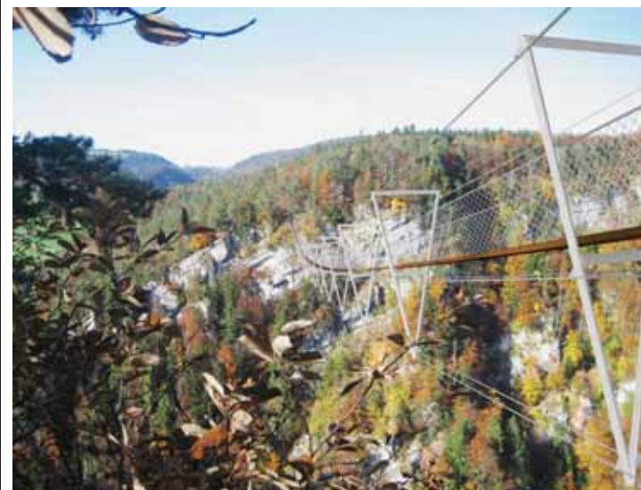
Une image de synthèse du pont, suspendu à 175 m au-dessus des gorges et ses six câbles porteurs. SP-ASSOCIATION PASSERELLE DU PICHOUX
